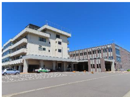
写真 多くの人が利用する小出病院
